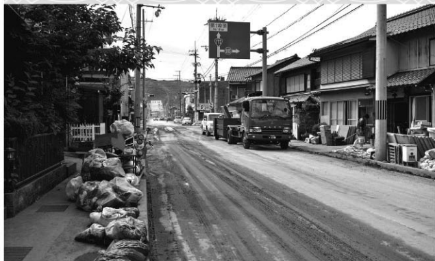
多くの家屋が浸水した魚屋地区（7月9日）
