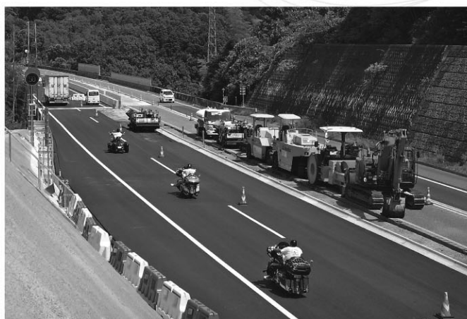
綾部PA付近 奥が「伊佐津川橋」
