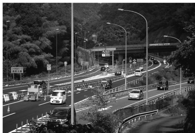
綾部側から見た舞鶴西IC付近の工事
