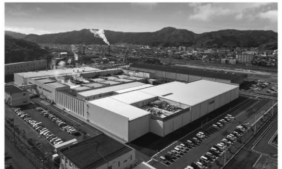
増設工事(右手前)が完成したケンコーマヨネーズ西日本工場
