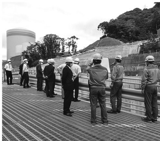
高浜発電所取水口の防潮ゲートの説明を受ける
